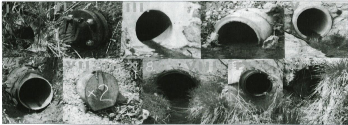
Teh enajst izpustov ima večji skupni premer, kot je trenutno premer potoka. - foto Marjan Trobec
