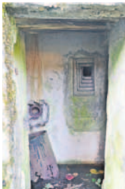
Pri večini bunkerjev je vhod v objekt varovala vhodna strelna lina, nekateri so bili opremljeni tudi s cevjo za izpust ročnih bomb (na fotografiji levo).
