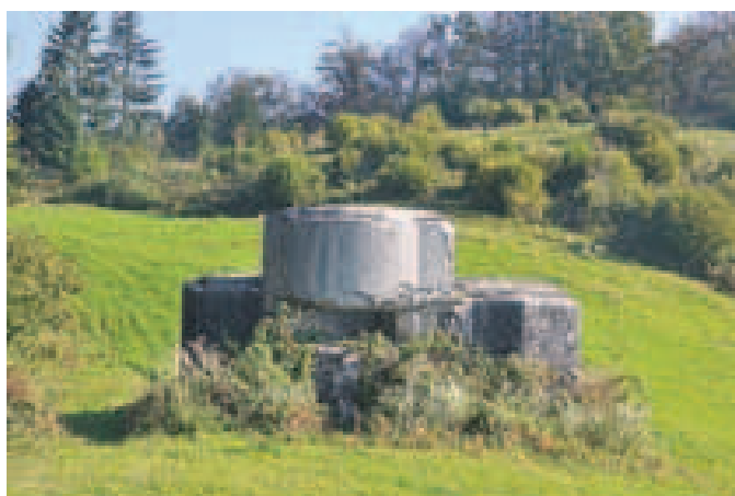
Tipski objekt s prepoznavnim stolpičem nad vasio Zaplana. Strop in stene so debele 100 cm, stolpič je bil namenjen opazovanju in frontalni obrambi (puškomitraljez).
