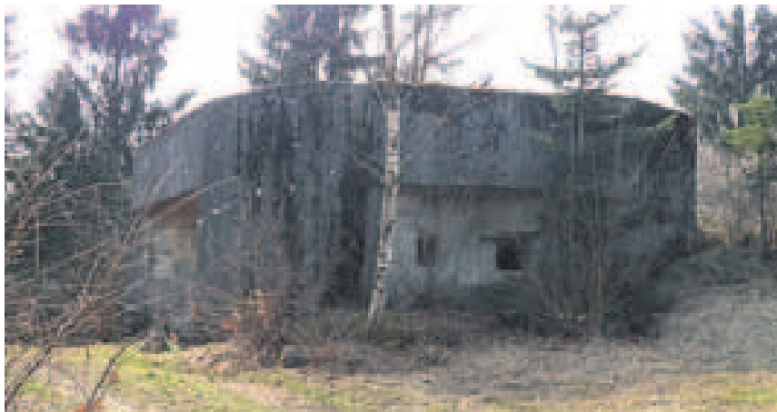
Dvostranski težak pehotni objekt nad Jezercem na Zaplani, ki velja za tamkaj najbolj izstopajočo utrdbo.
