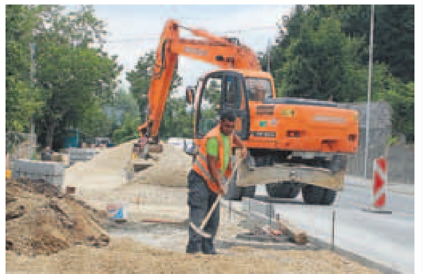
Gradnja kanalizacije na Lukovici
