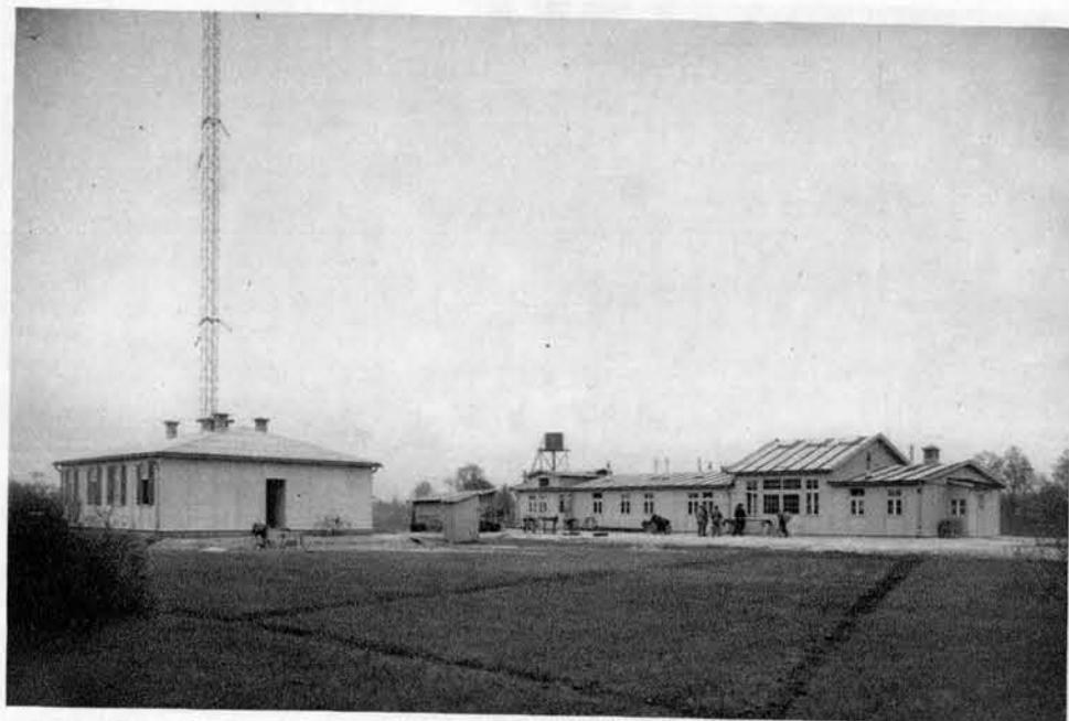
Pogled na zgradbe radio postaje v Domžalah.
