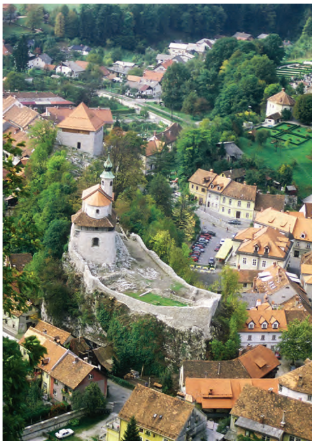
Slika 2. Sanirano obodno zidovje, kapela in stolp na Malem gradu 2004 (foto: M. Sagadin).
