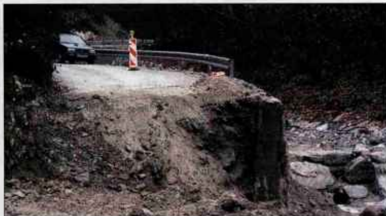
Septembra odprta regionalna cesta v Davčo je od nedelje zaradi porušenega opornega zidu znova zaprta za promet. / Foto: Goran Kavčič
