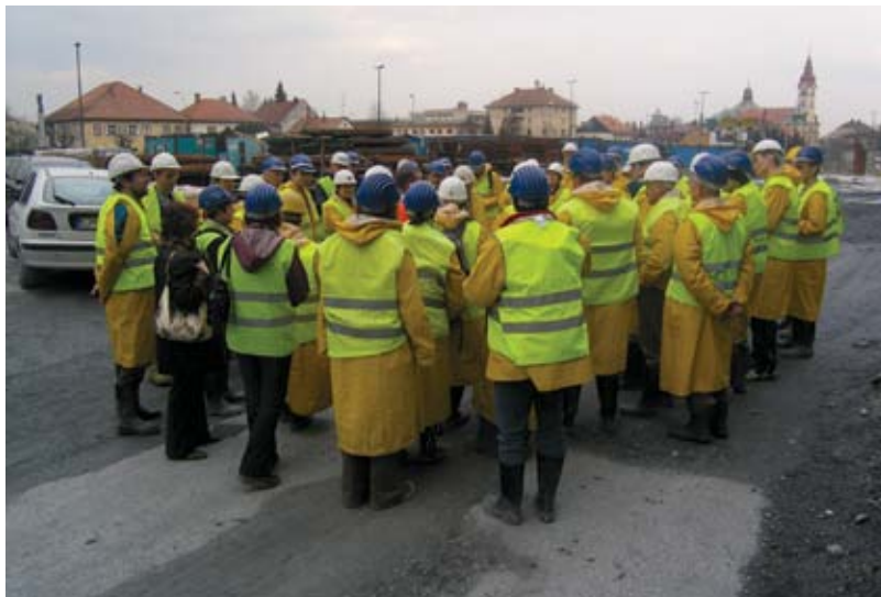
Slika 2: Obisk predora Šentvid v gradnji, 2. april 2007 (foto: Primož Pipan).
