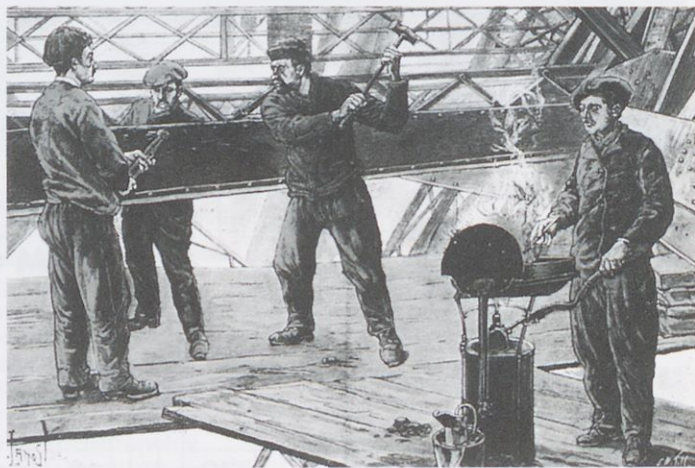
Slika 4. Utrjevanje ene izmed 2,5 milijona zakovic, ki spajajo okrog 15.000 jeklenih elementov
