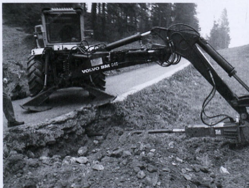
Kopanje trase kablovoda. Foto: Jože Lazar
