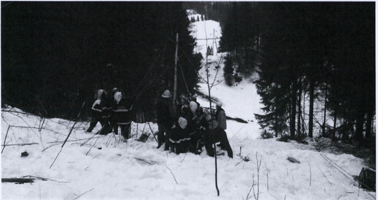
Vzpostavljanje zasilnega električnega omrežja nad Podklancem. Foto: PGD Zavrtec
