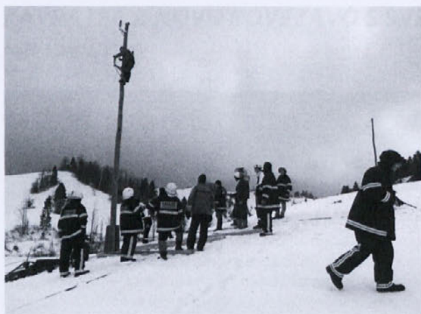
Menjava električnega droga v Potoku. Foto: PGD Zavratac
