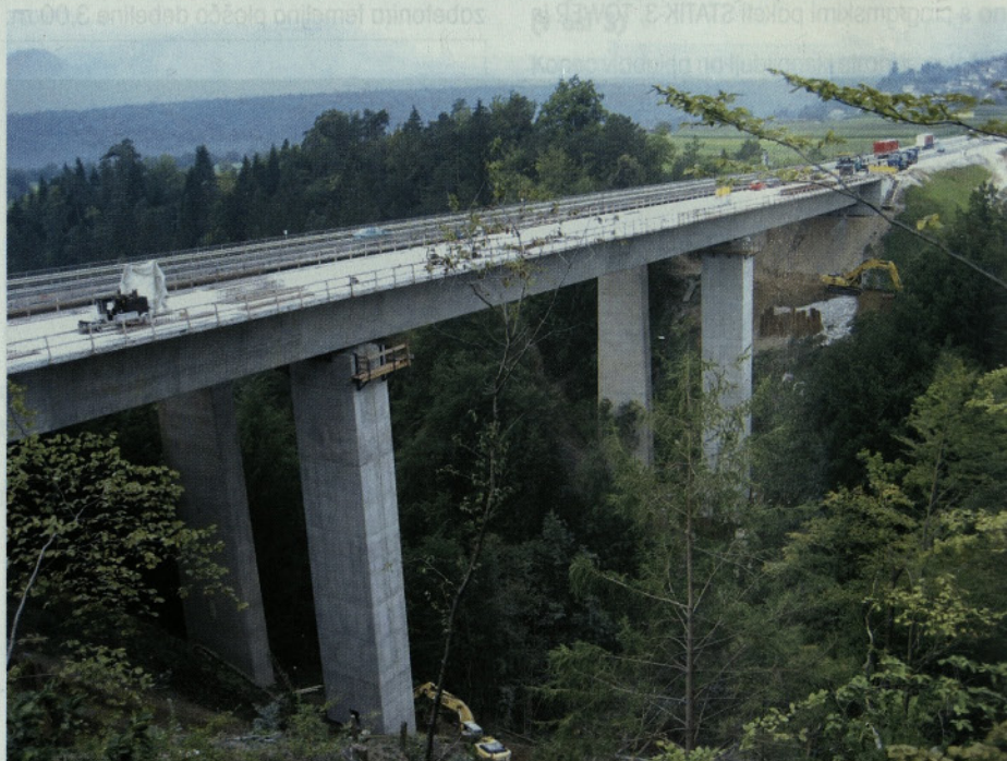
Slika 9 • Končana konstrukcija viadukta
