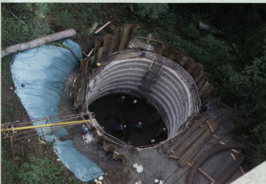
Slika 7 • Gradnja vodnjaka za temeljenje stebra
