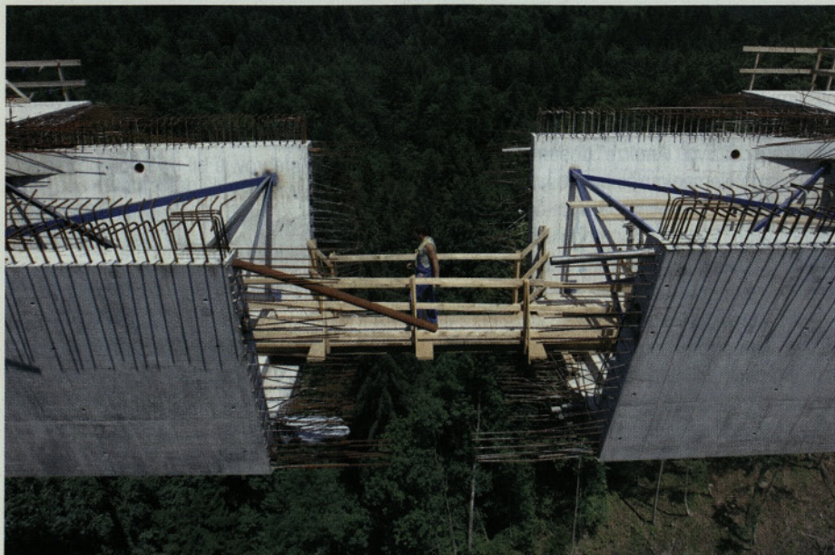
Slika 8 • Pred izdelavo vezne lamele med oba narinjena dela objekta
