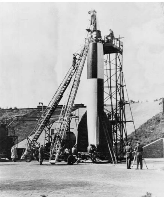
Prvi predmet, ki ga je izdelal človek in je poletel v vesolje, je bila skoraj 13 let pred Sputnikom 1 (leta 1944) raketa V-2, ki je med vertikalnim balističnim poletom iz nemškega poskusnega izstrelišča Peenemunde poletela na suborbitalni polet in takrat dosegla višino 176 kilometrov, kar je precej višje od 100 kilometrov, ki velja za rob vesolja. Po koncu druge svetovne vojne so se inženirji in znanstveniki, ki so razvijali raketo V-2, preselili v ZDA. (Foto: NASA-MSFC)
