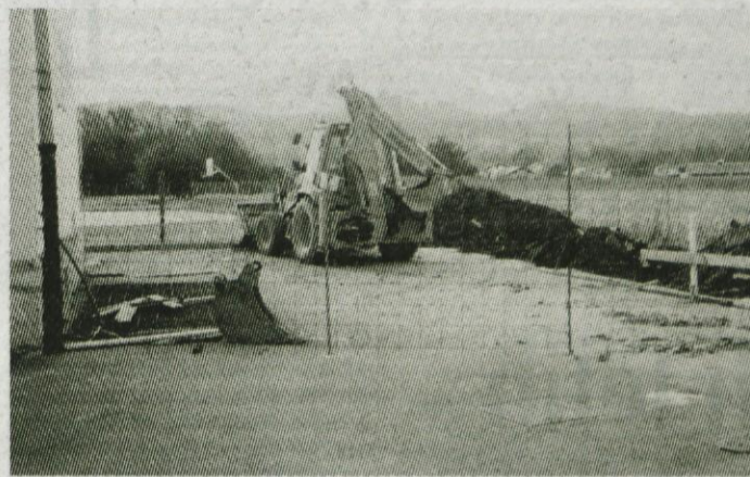
Gradbeni stroji so že začeli z izkopom temeljev nove ATC v Krtini.
