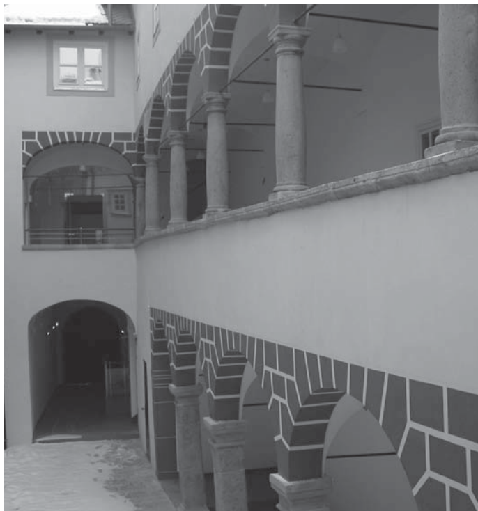
Slika 4: Ker zaradi drobnolastniških razmerij ni bilo možno obnoviti celega območja, smo skladno s pravili stroke obnovili (ga. Jadranka Grmek) vsaj en objekt. Ljubljana, Križevniška ulica 7.
