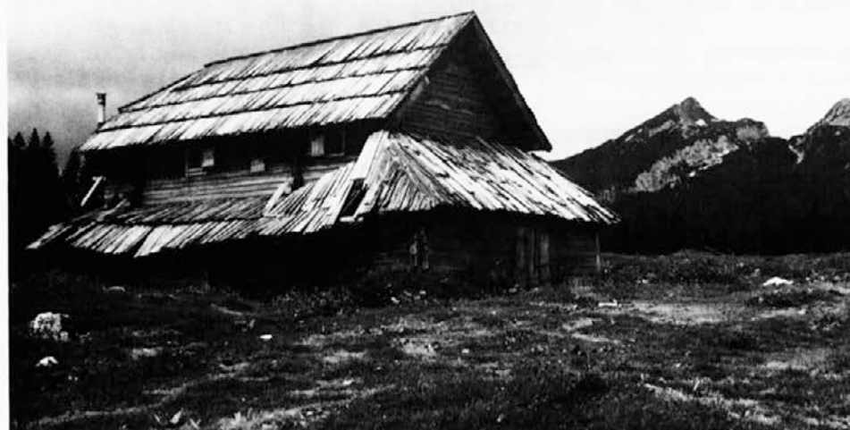
12 Nadstropni stan s hlevi ob podolžnih stenah in zadnji čelni steni, planina Javornik (1300m), /Stockhütte mit Ställen an der Längsseiten und an der Stirnseite, Alm Javornik/ T. Cevc, 1982
