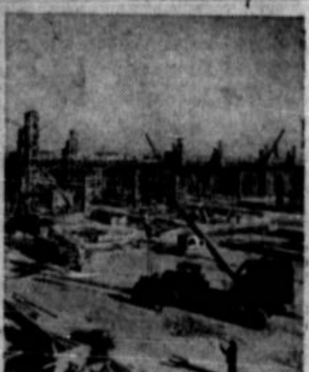
Električna sila je igrala svojo vlogo tudi pri gradnji oklepov za betoniranje.
