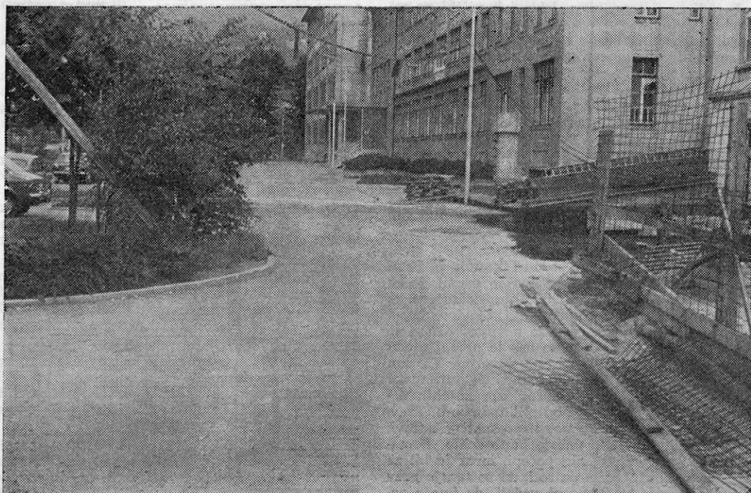
Delavci SGF Tržič so popravljali streho in razne remonte. Parkirni prostor je bilo skladišče materiala
