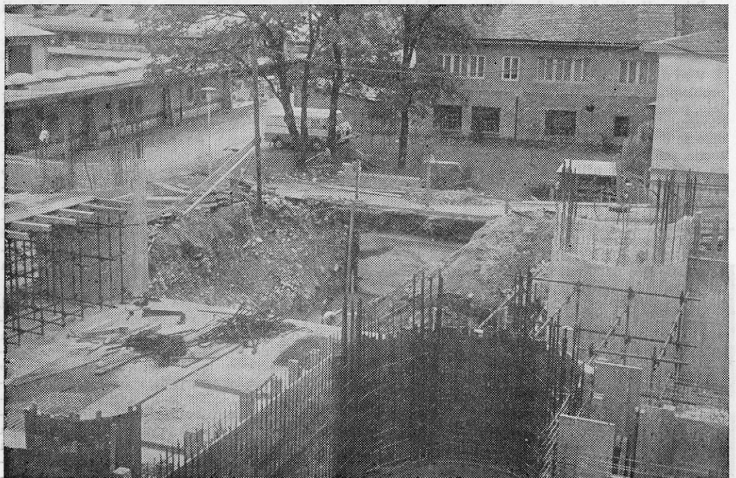
Zaradi izkopa za izhod iz zaklonišča je prekopana cesta pod glavno vratarnico.
