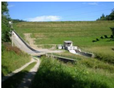
Slika 7 • Pregrada Klivnik z izpustom vode
