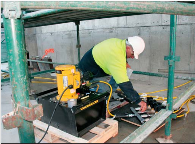
Slika 3. Hidravlični agregat z visokotlačno črpalko in krmilnim modulom z ročnimi ventili
