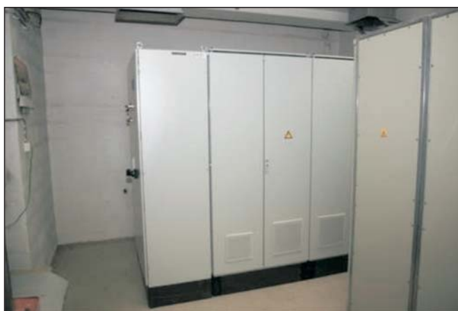
Slika 1. Omare, v katerih so moduli Unidrive SPM . Omare so zaprte, ker bi odpiranje vrat ustavilo proizvodnjo.
