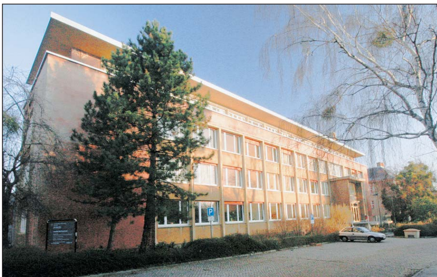
Zgradba Inštituta za fluidno tehniko v Dresdnu – Kutzbach-Bau
