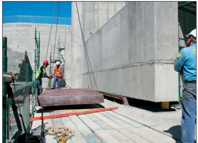
Slika 4. Dviganje sekcije varnostne pregrade s pripravljeno vmesno podložno ploščo
