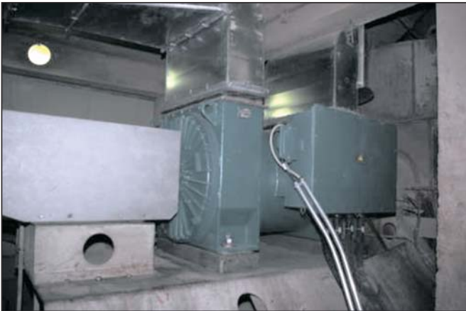
Slika 3. Motor 1 MW, 690 V podjetja Leroy Somer (teža nad 6t)
