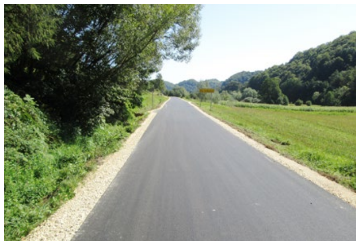
Preplastitev lokalne ceste Leskovec–Podlehnik
