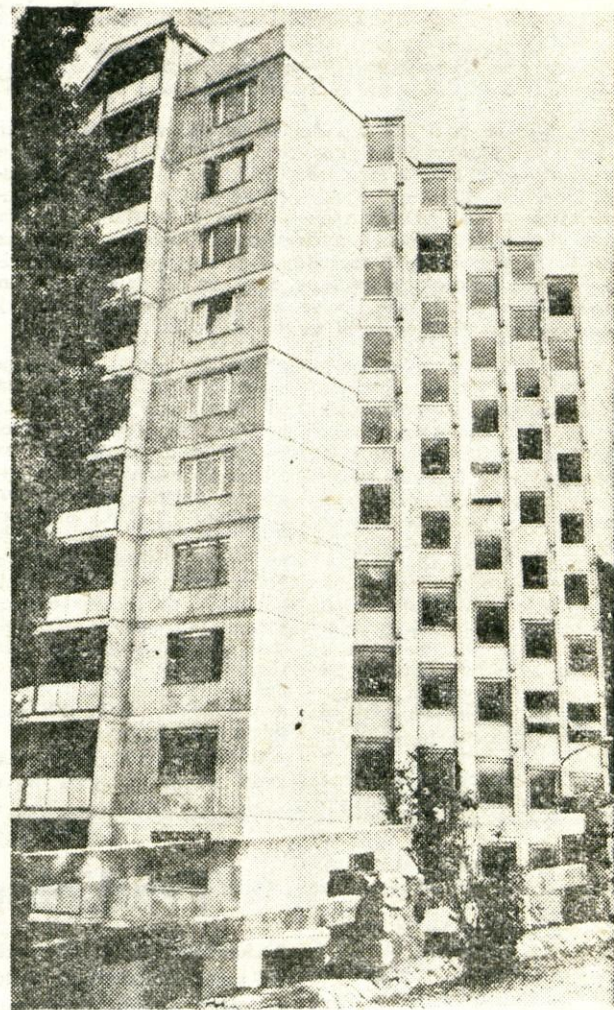
Končno bo tudi tržiška stolpnica dograjena. S prvim septembrom bo predvidoma vseljiva. V stolpnici bo 58 stanovanj in trije lokali podjetij Murka Lesce, Tobak Ljubljana in SAP. — Foto: F. Perdan
