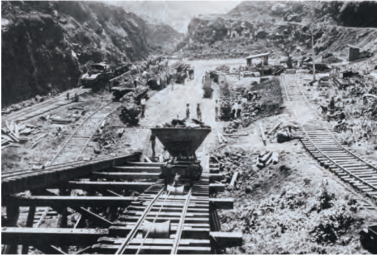
Gradnja Panamskega kanala leta 1907. Vir: Google slike.
