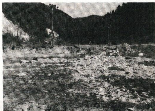
S kamenjem in gramozom zasut travnik in poškodovano cestišče v Lukovici
