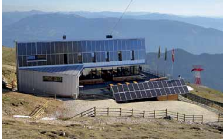
Koča na Dobraču povprečno obišče 300 ljudi na dan, poleti in pozimi. Zaradi dobre izolacije in sistema prezračevanja jo je komaj kdaj potrebno ogrevati. Foto: Aleš Glavnik
