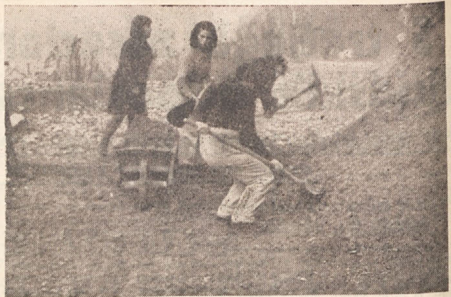
Skupina brigade »Simona Kosa«, ki gradi cesto v Nemški Rut, pripravlja grušč za posipanje cestišča.
