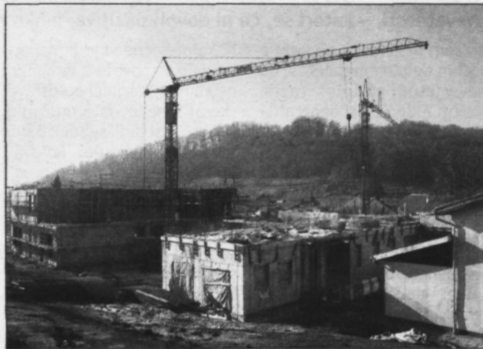
Gradbišče OŠ Bizeljsko
