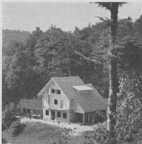
Planinska koča na Bohorju (v gradnji)
