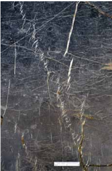
Slika 16: Bele kalcitne žile v strižni coni na stopnici iz zgornjetriasnega lesnobrdskega apnenca pred glavnim vhodom v cerkev sv. Jakoba. Foto: Matevž Novak.
