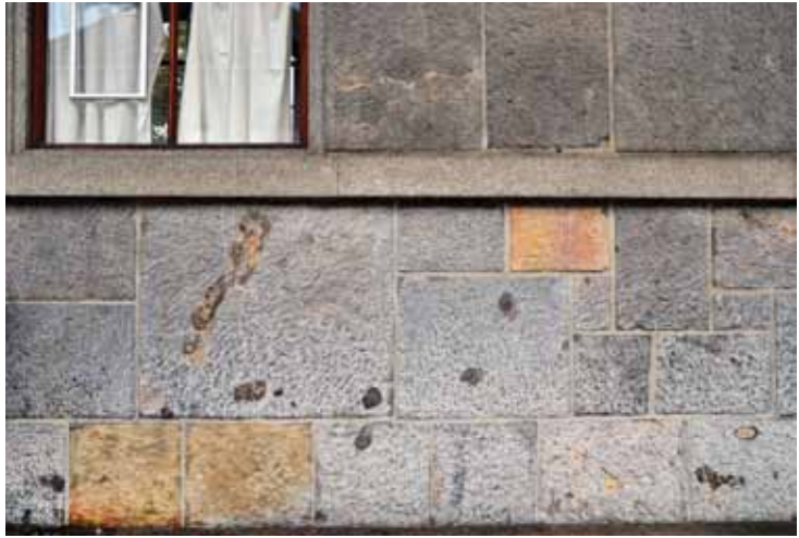
Slika 12: Gomolji temnega roženca v škofjeloškem apnencu poznotriasne ali zgodnjejurske starosti v arkadah Plečnikovih tržnic. Foto: Matevž Novak.
