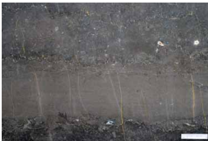
Slika 9: Rumeni stilolitni šivi v jurskem apnencu iz Podpeči v stenski plošči vhodnega stopnišča stavbe Montanistike na Aškerčevi cesti 12. Foto: Matevž Novak.
