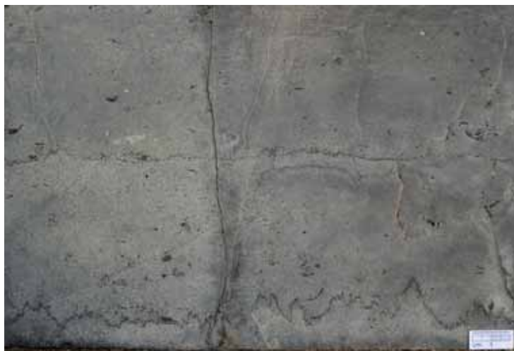
Slika 10: Stilolitni šivi v podpeškem apnencu v zgornji plošči kamnite ograje razgledne terase na severovzhodnem delu obzidja Ljubljanskega gradu.
