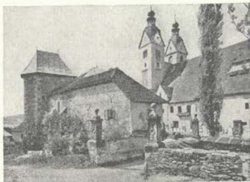
Dohod k cerkvi z južne strani prek obrambnega jarka
