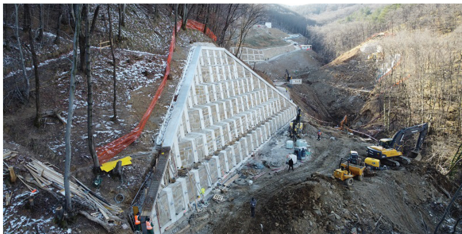
Slika 2 • Oporni zid ob osrednjem delu premostitvenega objekta.
