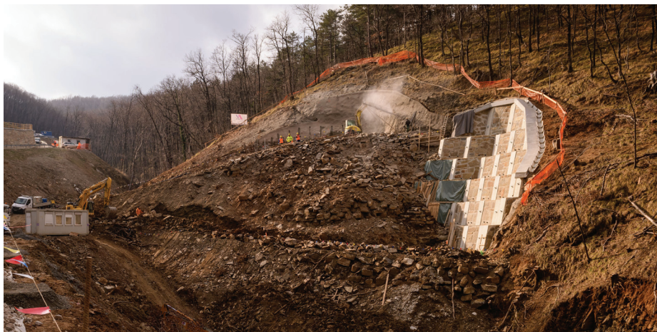
Slika 3 • Oporni zid in zaščita predvropa predora T2.
