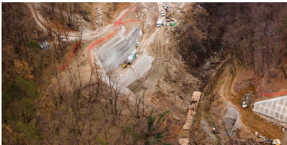
Slika 1 • Zaščita predvropa predora T1 in gradbene jame opornika premostitvenega objekta.
