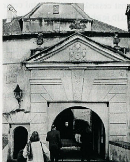
Schlaining: grajski portal
