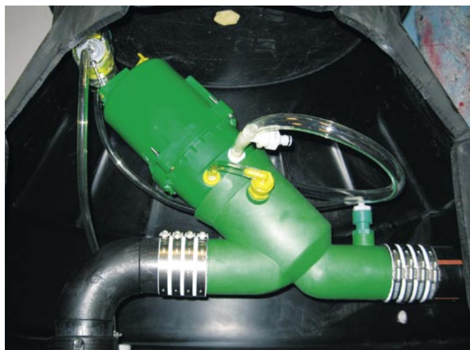
Slika 2 • Standardni batni ventil FLOVAC DN 80
