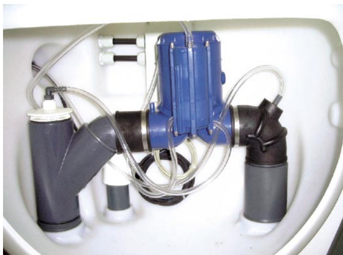
Slika 1 • Standardni 2" membranski ventil ROEVAC
