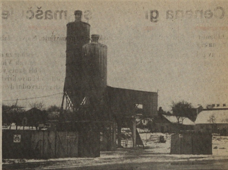
Betonarna ne obratuje že od junija lani, vendar še vedno stoji na gradbišču soseske Rabelčja vas. Ker težko dobijo beton, bodo Gradnje kupile lastno betonarno.
