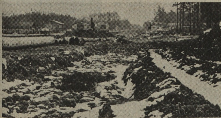
Ptujska cesta — del bodoče štiripasovnice — prestaviti je trebalo vodovod, kanalizacijo, telefonski kabel...
