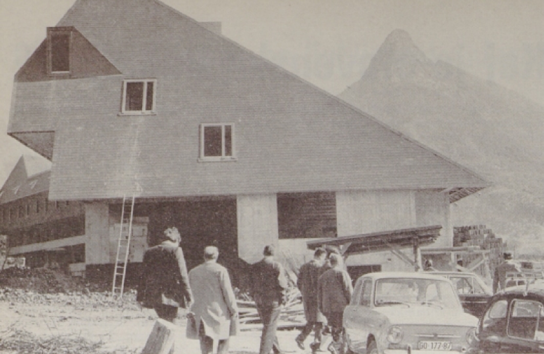
Novi bovški hotel med gradnjo
