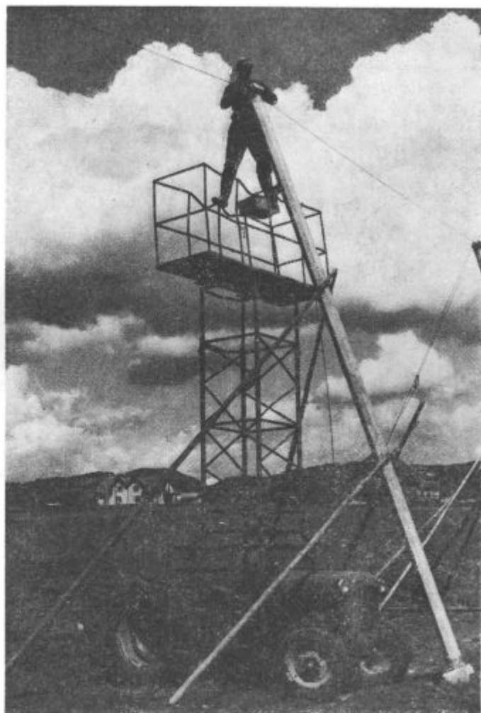
Gradnja betonske hmeljske žičnice
