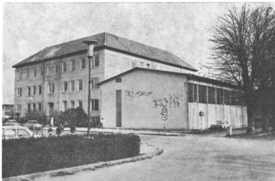
Obnovljena in dozidana (nova telovadnica) šola v Žalcu
