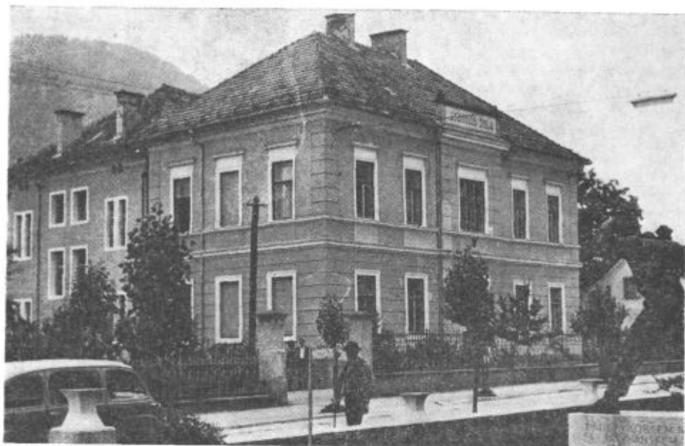
Sola na Vranskem pred obnovitvijo
