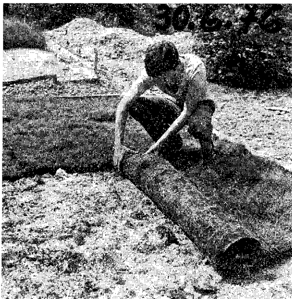
Sl. 3 — Polaganje tratnega zvitka Abb. 3 — Das Legen des Roll- rasens
