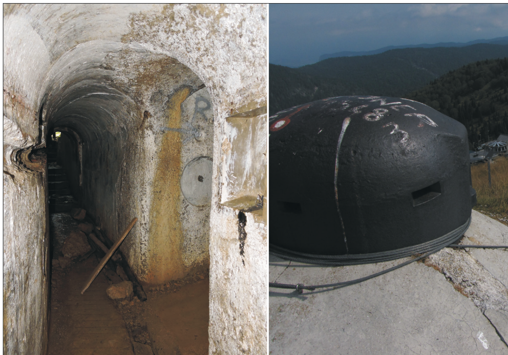
Slika 6: Podzemna italijanska utrdba pri Unški koliševki 80 (levo), največji utrdbi Alpskega zidu na Slovenskem 81 in topniška opazovalnica z jekleno kupolo na Lajnarju 82 nad Soriško planino (desno) (fotograf: Matija Zorn).
