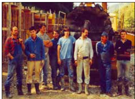
Delovna akcija: izdelava betonskega opornega zidu (v ozadju).
