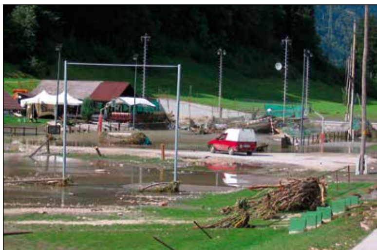
Asfalt na roketnem igrišču je bil dodatno razpokan, uničeni so bili zaščitne mreže z nosilci, ograja, goli in koši za streetball.
