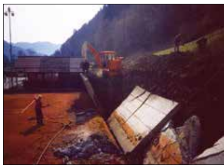
Sanacija opornega zidu na igriščih za tenis.
