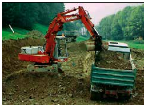
Izkop zemlje za teniško igrišče.
