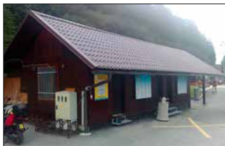
Obnovili smo stavbno pohištvo in jo na novo prebarvali.
