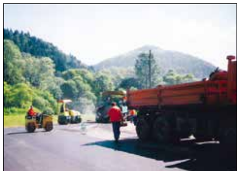
Nove asfaltne poti.
