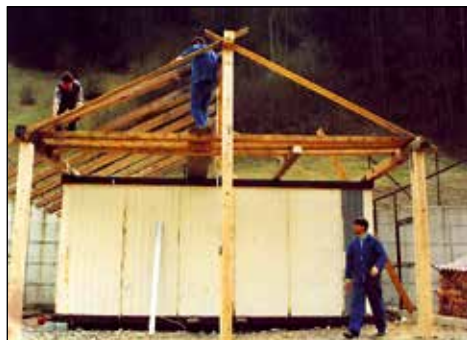
Nastaja streha nad kontejnerjem.
