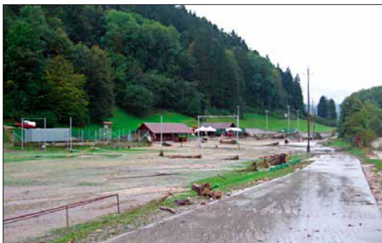
Uničeni so bili travnata površina nogometnega igrišča, zaščitne mreže z nosilci ter ograja, goli in klopi.
