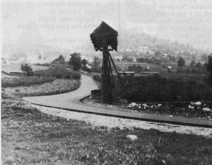
Asfalt na cesti Gorje – Poljšica
