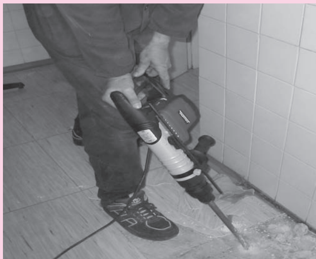
□ Slika 7. Dolbenje betonskih tal
