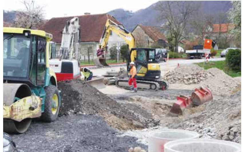
Izgradnja krožnega križišča
