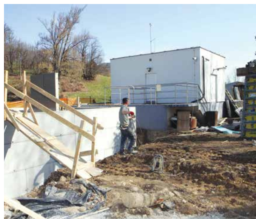
Gradnja II. faze čistilne naprave
