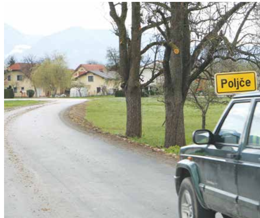
Del obnovljene ceste
