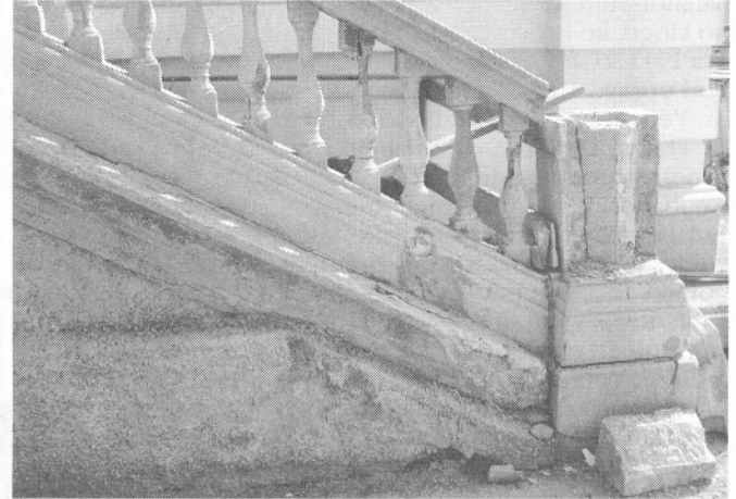
Sl. 3. Pričetek obnove stopnišča.
