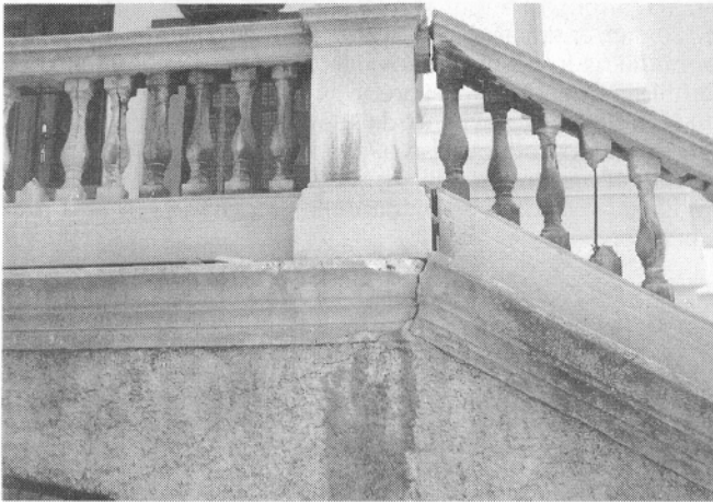
Sl. 2. Stopnišče pred obnovo.
