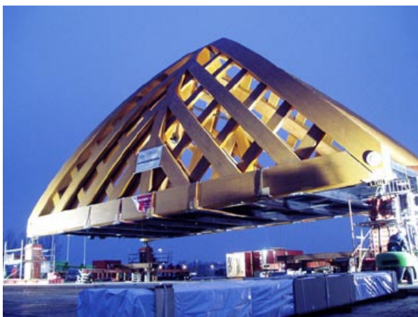
■ Slika 1. Most iz acetiliranega lesa na Nizozemskem ( http://www.accoya.com/ )
