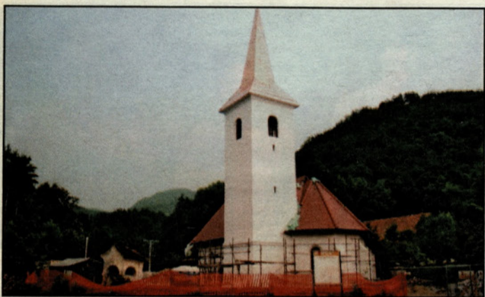
Cerkev sv. Mihaela v Šmartnem ob zaključku gradbenih del
