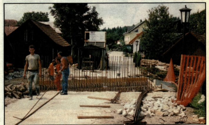
Gradnja mostu čez potok Trebnik v Braslovčah
