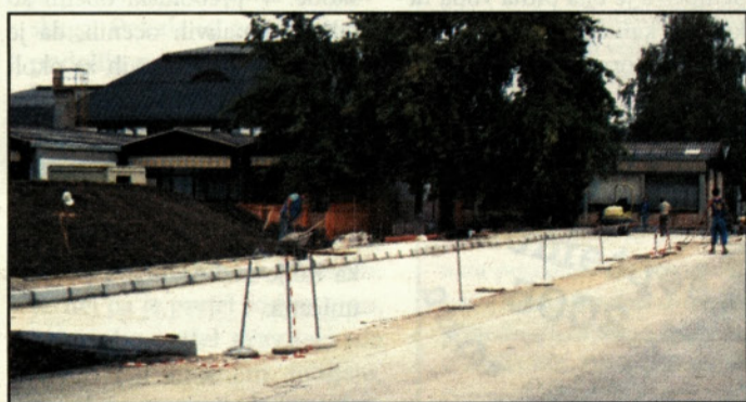
Novo parkirišče pri vrtcu
