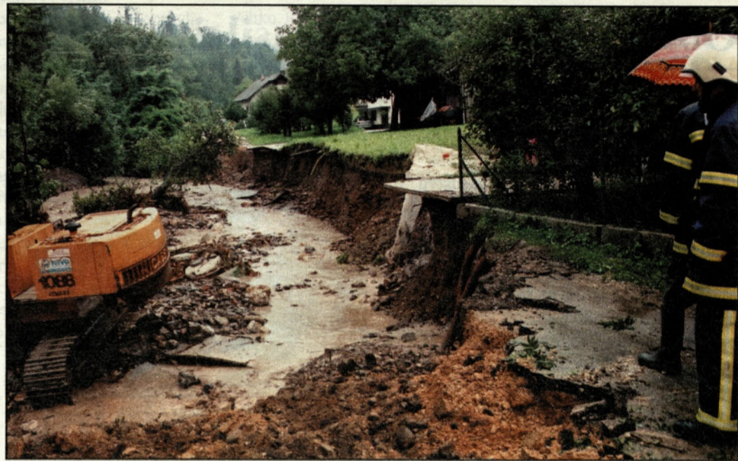
Del ceste v Zabukovici je voda odnesla
