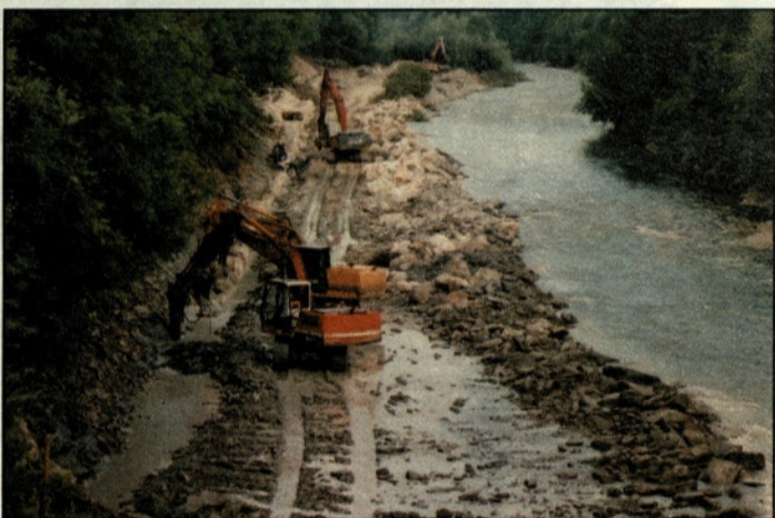
Sanacija desnega brega Savinje v Parižljah
