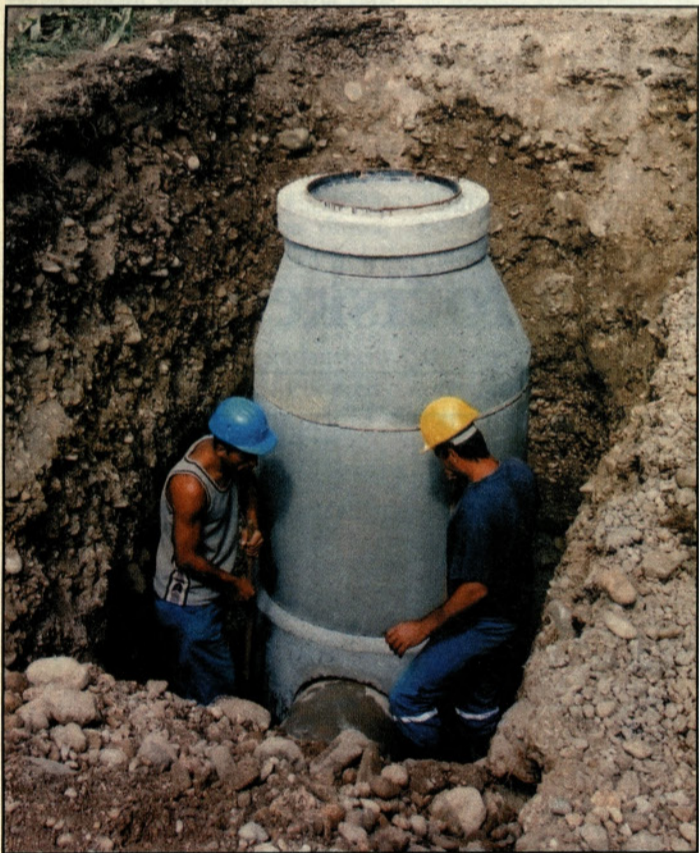
Podjetje NIVO Celje gradi kanalizacijski zbiralnik pred razbremenilnim kanalom.
