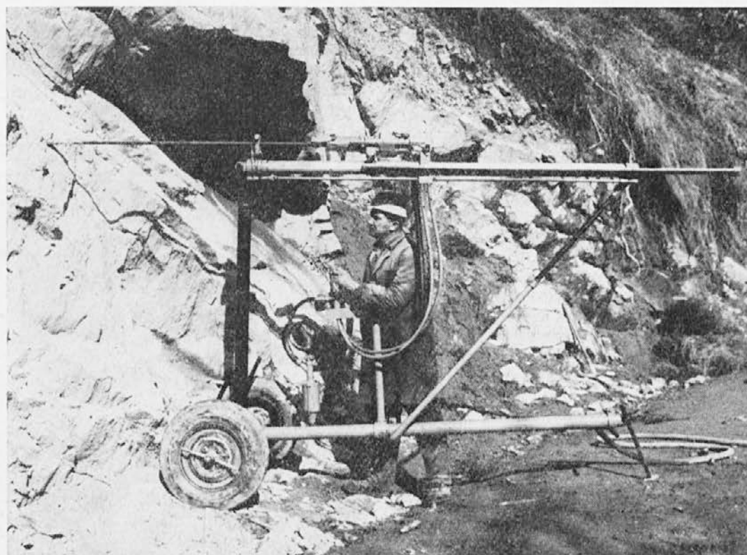
Slika 4 — lažji lafetni pnevmatični vrtalni stroj RUTL, proizvod Železarne Ravne
