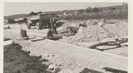
Prav na Stolov dan je bila prekopana Korenova pot ob našem dupliškem Interieru. Treba je bilo zaščititi plinski vod, predno so delavci cestnega podjetja nadaljevali z graditvijo te ceste, ki je postala preozka.
