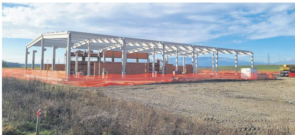
Podjetje Pomlad Gerečja vas je že začelo graditi skladiščni objekt.
