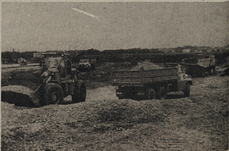
Stroji pripravljajo teren za gradnjo novih proizvodnih prostorov za Kovinske obrate iz Ljubljane
