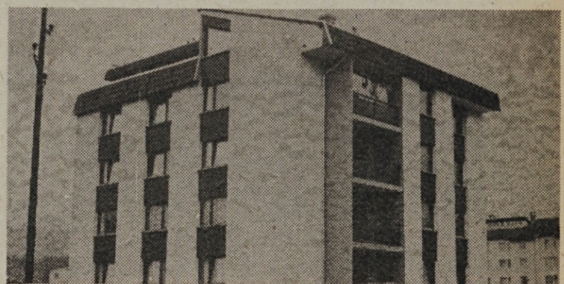
Samski dom v Slovenj Gradcu je že zgrajen. Lep je in udoben
