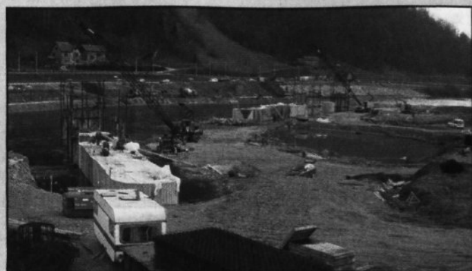
V ozadju delovni stroj za Benotto pilote med 2. in 3. delovnim platojem in še bolj v ozadju dolvodna kamnita obloga brežine.
