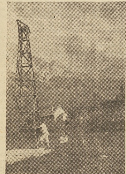
Zaenkrat vidite na sliki samo en železen nosilec. Toda ne bo več dolgo, ko bodo takšni nosilci postavljeni do vrha Vitranca, kamor se boste lahko peljali z lepo sedežnico
