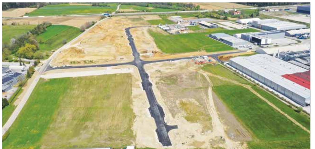
Pogled na obsežno območje Arnovskega gozda III v gradnji s ptičje perspektive
