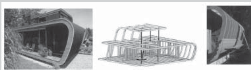
□ Slika 3. Alternativna arhitekturna lupina enodružinske hiše z lesenim ogrodjem. Lepljeni nosilci so obojestransko obloženi z lesenimi deskami, med katerimi je toplotna izolacija. Zunanja troslojna obloga, ki je za vodo neprepustna zaščita lesene konstrukcije, pa je iz bitumna. (Bügelmayer 2004)
