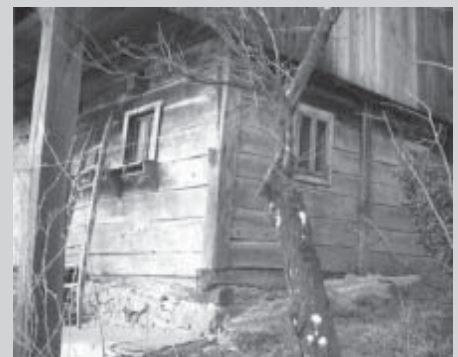
□ Slika 8. Stene Majerjeve hiše na Dolžu so iz plohov, vstavljenih v utore konstrukcijskih stebrov in postavljene na nosilne talne lege, ki ležijo na kamnitih podstavkih. (Kobe, 2005)
